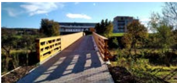
Lávka s novou klubovnou (vlevo) a bytovým domem Foto: Prague City Golf
